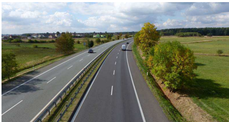
Droga krajowa S1 (wschodnia obwodnica GOP) – widok z wiaduktu (ul. Zawiszy Czarnego) w kierunku zachodnim.
