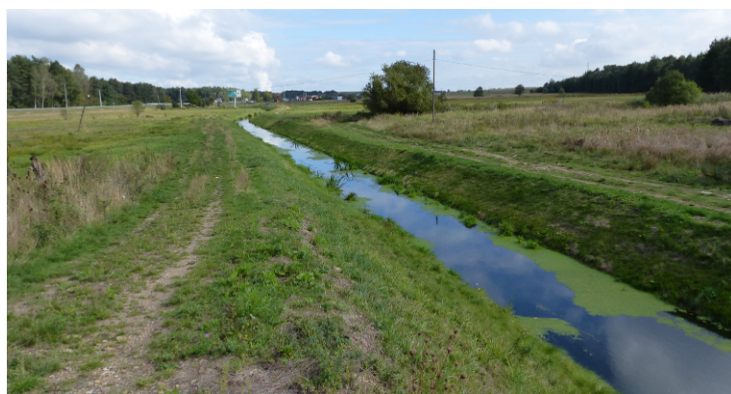
Przyrwa (Potok Ławecki) - koryto ciek jest prostoliniowe, wyregulowane, posiada obudowę techniczną
