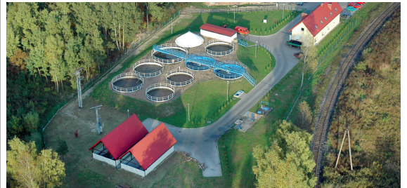
Oczyszczalnia ścieków - Hołdunów
