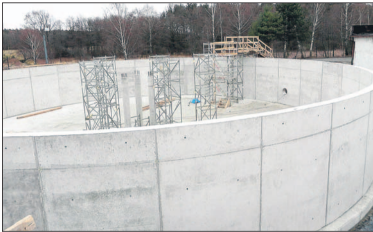
Nowo wybudowany osadnik wtórny.
