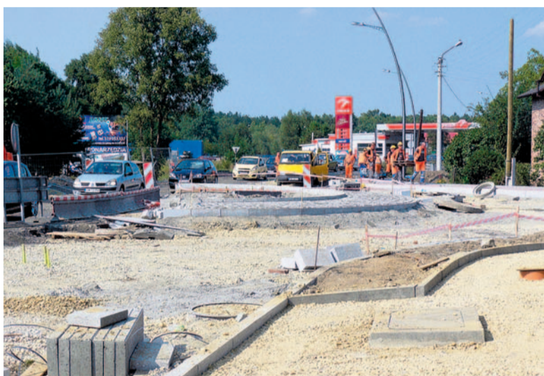
Stan prac na rondzie w dniu 13 sierpnia.
