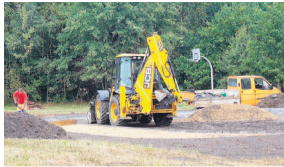
Prace przy budowie placu zabaw przy ul. Murckowskiej.
