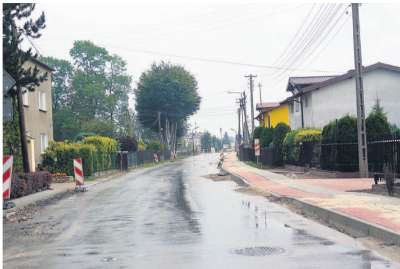
Wykonany chodnik przy ul. Murckowskiej.
