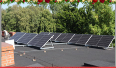
ZABUDOWA SYSTEMU ODNAWIALNYCH ŹRÓDEŁ ENERGII W BUDYNKACH SZKOŁY PODSTAWOWEJ NR 3 W ŁĘDZINACH
