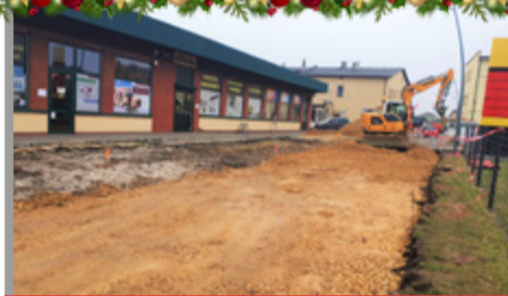
PRZEBUDOWA UL. DZIAŁKOWCÓW - 2 ETAP - INWESTYCJA W TRAKCIE REALIZACJI
