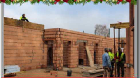
ROZBUDOWA SZKOŁY PODSTAWOWEJ NR 2 W ŁĘDZINACH - INWESTYCJA W TRAKCIE REALIZACJI
