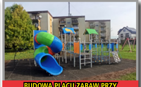
BUDOWA PLACU ZABAW PRZY UL. BOTANICZNEJ OSIEDLE GWARKÓW, PROJEKT I WYKONANIE
