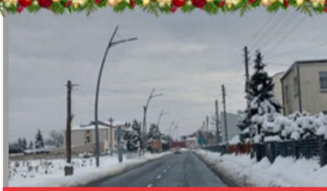
BUDOWA OŚWIETLENIA DROGOWEGO UL. MURCKOWSKA
