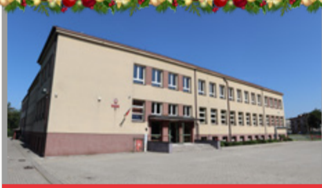
WYMIANA OKIEN W BUDYNKU SP3
