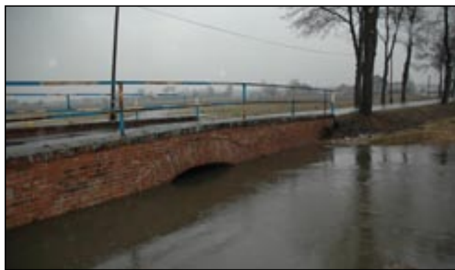
Tak wygląda obecnie odcinek Przyrwy podczas wiosennych roztopów i silnych opadów deszczu.
