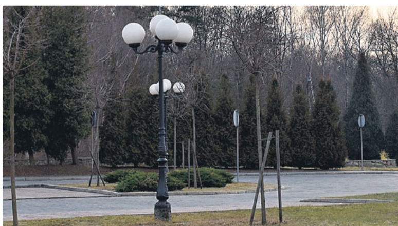
Lampy na parkingu przed Urzędem Miasta również będą wymienione w ramach projektu.
