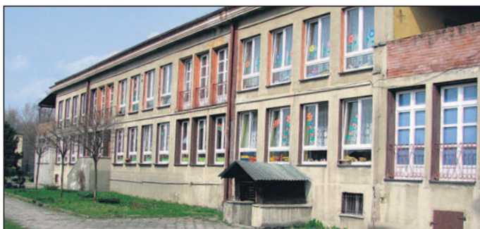
Przedszkole przed remontem.
