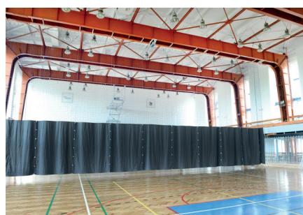
ZAMONTOWANA AUTOMATYCZNIE ROZKŁADANA KURTyna DO ROZDZIELANIA BOISKA NA HALI SPORTOWEJ
