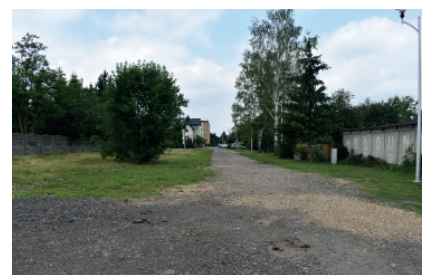
BUDOWA NAWIERZCHNI ASFALTOWEJ NA ULICY KWIATOWEJ
