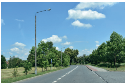
BUDOWA NOWEGO OŚWIETLENIA DROGOWEGO - UL. POKOJU (OD UL. ŁĘDZIŃSKIEJ DO PRZEJAZDU KOLEJOWEGO)
