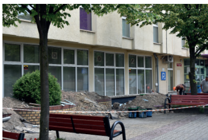
TERMOMODERNIZACJA URZĘDU MIASTA
