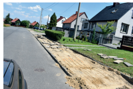
REMONT CHODNIKA I WODOCIĄGÓW NA UL. LEWANDOWSKIEJ
