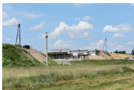
BUDOWA WĘZŁA KOMUNIKACYJNEGO „OLSZYCE”
