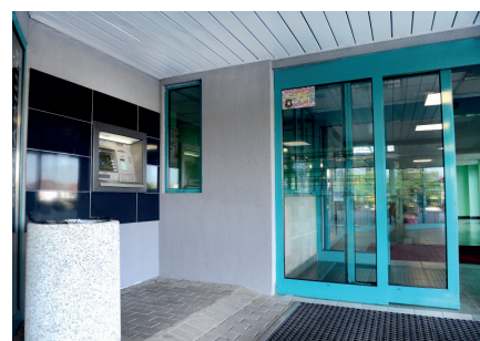
ODNOWIONA ŚCIANA BANKOMATU NA ZEWNĄTRZ BUDYNKU
