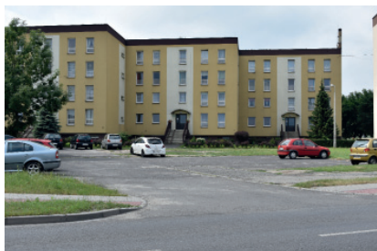
BUDOWA PARKINGU PRZY ULICY GWARKÓW
