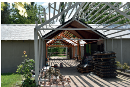
REMONT PERGOLI NA TERENIE OŚRODKA ZALEW
