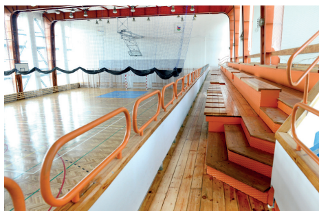
WIDOWNIA HALI SPORTOWEJ PO WYREMONTOWANIU
