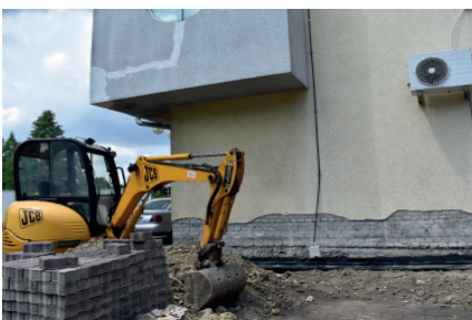
TERMOMODERNIZACJA URZĘDU MIASTA
