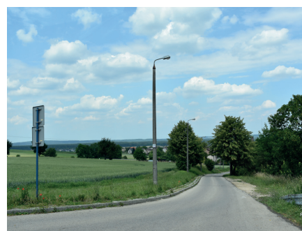
WYMIANA OŚWIETLENIA I REMONT CHODNIKA PRZY UL. ZABYTKOWEJ
