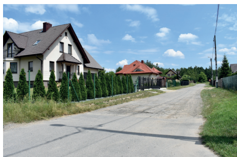
BUDOWA NAWIERZCHNI ASFALTOWEJ I OŚWIETLENIA DROGOWEGO - UL. LIPCOWA
