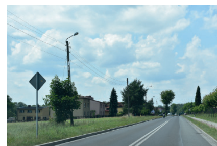
BUDOWA NOWEGO OŚWIETLENIA DROGOWEGO - UL. POKOJU (OD UL. JAGIELLOŃSKIEJ DO WIADUKTU)
