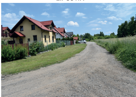
BUDOWA DROGI I OŚWIETLENIA DROGOWEGO PRZY UL. PANORAMY
