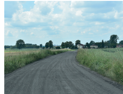
BUDOWA DROGI I OŚWIETLENIA DROGOWEGO NA UL. BLYCH
