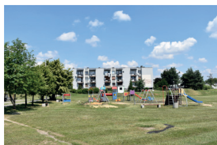
BUDOWA BOISKA NA OSIEDLU CENTRUM
