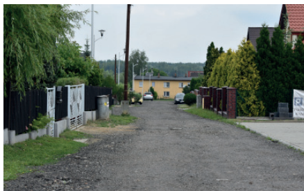
BUDOWA NAWIERZCHNI ASFALTOWEJ NA ULICY SOSNOWEJ
