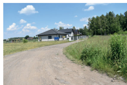
BUDOWA DROGI I OŚWIETLENIA DROGOWEGO PRZY UL. ZACISZE
