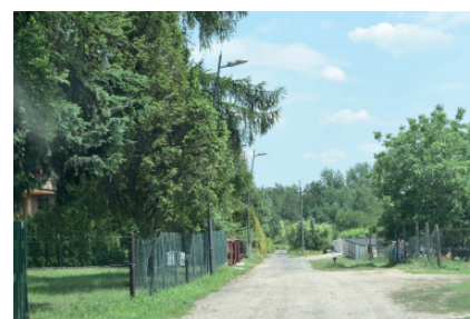
BUDOWA NAWIERZCHNI ASFALTOWEJ PRZY UL. SZKOLNEJ
