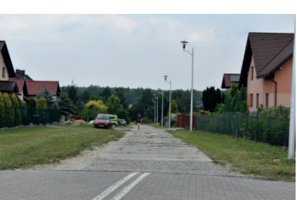
BUDOWA NAWIERZCHNI ASFALTOWEJ NA ULICY POGODNEJ
