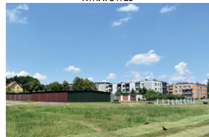
BUDOWA OŚWIETLENIA GARAŻY NA OSIEDLU CENTRUM
