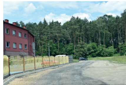
REMONT DROGI ZA BUDYNKIEM MKS LĘDZINY
