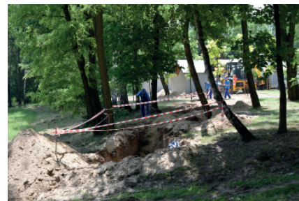
REMONTY ZWIĄZANE Z KANALIZACJĄ - OŚRODEK ZALEW
