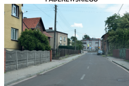
REMONT CHODNIKA PRZY UL. SOBIESKIEGO
