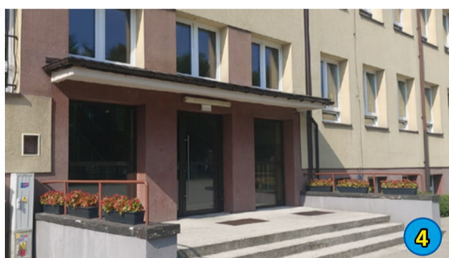
4. TERMOMODERNIZACJA BUDYNKU SZKOŁY PODSTAWOWEJ NR 3 W ŁĘDZINACH - 31 980,00 ZŁ
