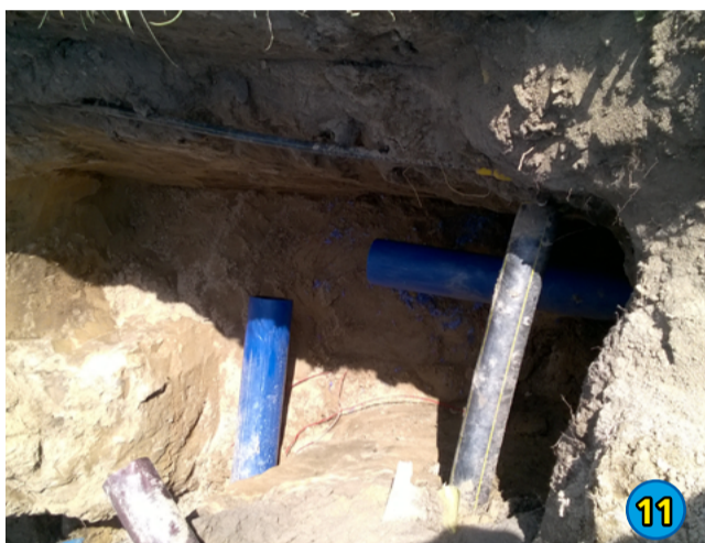
11. Budowa sieci wodociągowej ul. Ławecka - 91 942,50 zł
