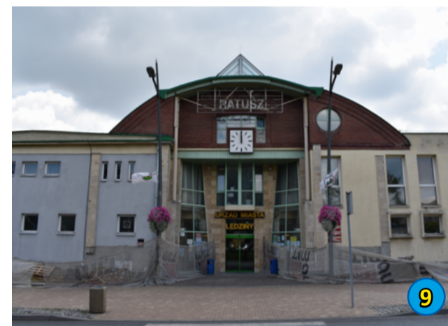
9. BUDOWA SIECI STRUKTURALNEJ BUDYNKU UM LĘDZINY - 99 990,45 ZŁ
