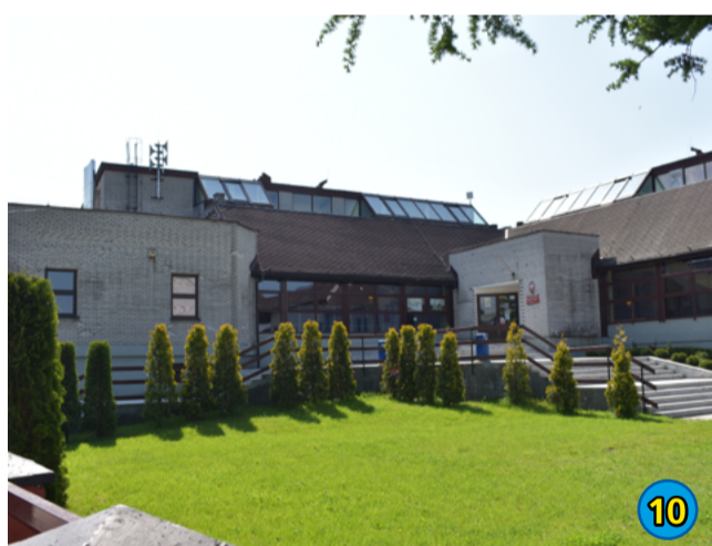
10. ZESPÓŁ SZKÓŁ NA GOŁAWCU - MODERNIZACJA - 39 975,00 ZŁ
