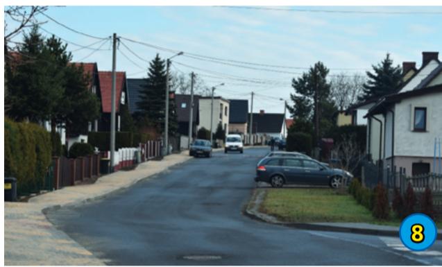
8. PRZEBUDOWA DROGI GMINNEJ UL. MICKIEWICZA W ZAKRESIE PRZEBUDOWY I BUDOWY CHODNIKA - 96 000,00 ZŁ
