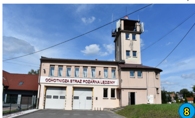
8. MODERNIZACJA DACHU BUDYNKU PRZY UL. KONTNEGO OSP - 79 059,27 ZŁ
