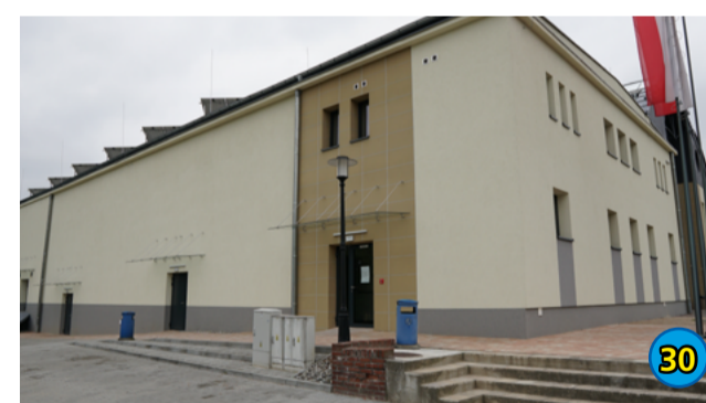
30. DOTACJA CELOWA NA MODERNIZACJĘ SANITARIATÓW SALI KINOWEJ MOK - 60 000,00 ZŁ
