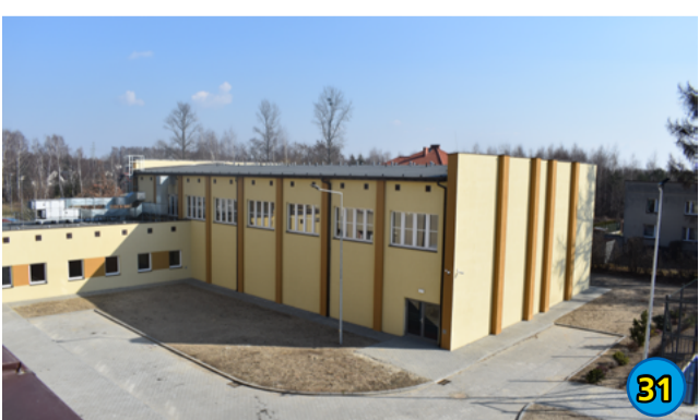
31. WPF - BUDOWA SALI GIMNASTYCZNEJ Z ŁĄCZNIKIEM DO BUDYNKU SZKOŁY PODSTAWOWEJ NR 1 W LĘDZINACH - 1 148 392,42 ZŁ
