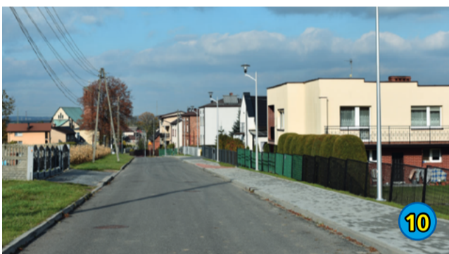
10. BUDOWA CHODNIKA I OŚWIETLENIA DROGOWEGO ULICY ZABYTKOWEJ W ŁĘDZINACH - 423 952,25 ZŁ
