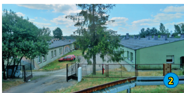
2. TERMOMODERNIZACJA BUDYNKU KOMUNALNEGO W ŁĘDZINACH PRZY UL. POKOJU 37 - 299 770,70 ZŁ
