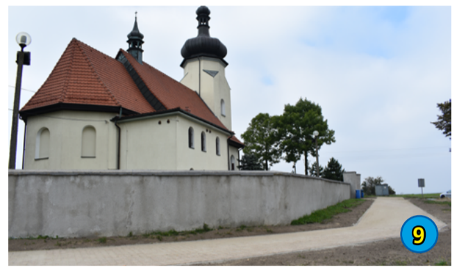
9. PRZEBUDOWA CHODNIKA WOKÓŁ KOŚCIOŁA ŚW. KLEMENSA - 102 901,41 ZŁ
