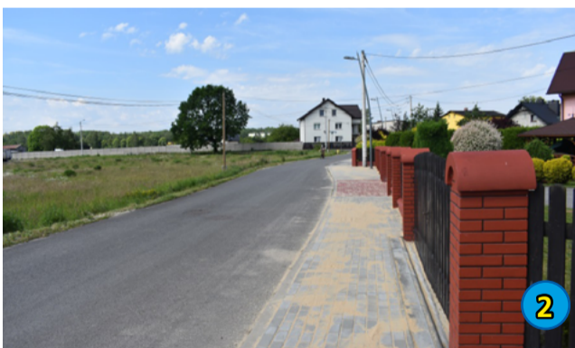
2. PRZEBUDOWA UL. MIŁEJ WRAZ Z BUDOWĄ OŚWIETLENIA DROGOWEGO - 254 118,00 ZŁ
