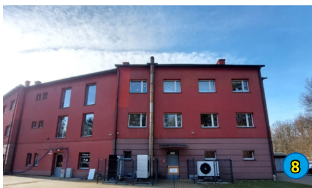
8. ADAPTACJA BUDYNKU PRZY UL. STADIONOWEJ W ŁĘDZINACH NA ŻŁOBEK MIEJSKI - 1 334 416,03 ZŁ
