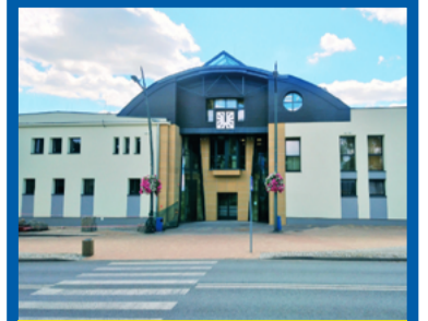
TERMOMODERNIZACJA BUDYNKU URZĘDU MIASTA W ŁĘDZINACH - 4 768 468,79 ZŁ
