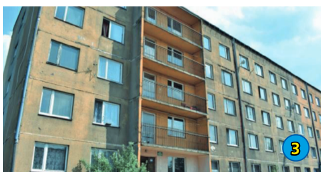
3. TERMOMODERNIZACJA BUDYNKU KOMUNALNEGO W ŁĘDZINACH PRZY UL. POKOJU 106 - 303 378,04 ZŁ
