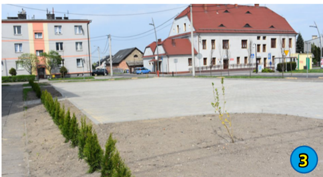
3. WYKONANIE MIEJSC PARKINGOWYCH PRZY UL. RUBERGA - XXV-LECIA - 106 433,36 ZŁ
