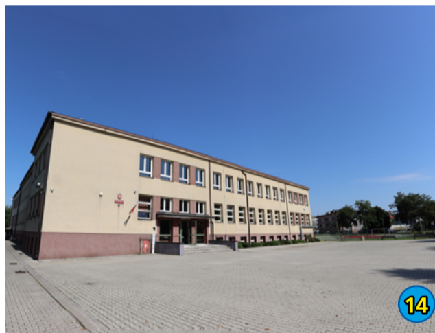
14. TERMOMODERNIZACJA BUDYNKU SZKOŁY PODSTAWOWEJ NR 3 W ŁĘDZINACH - 337 265,80 ZŁ
