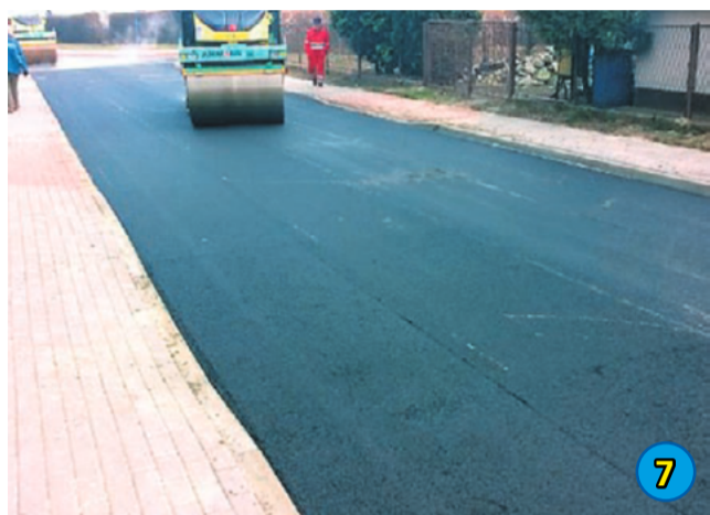
7. WYKONANIE NAWIERZCHNI DRÓG UL. WANDY I DĘBOWA, REMONT CHODNIKA UL. WANDY - 246 528,90 ZŁ
