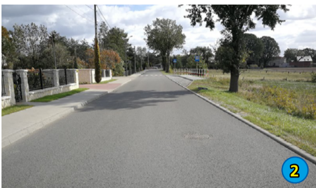
2. BUDOWA CHODNIKA - UL. UŁAŃSKA DOTACJA DLA POWIATU - 372 198,29 ZŁ
