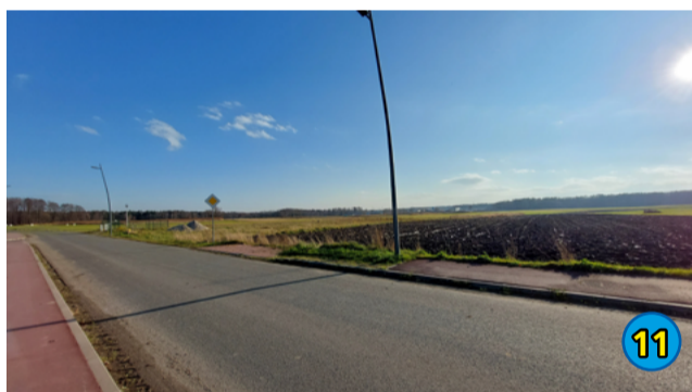
11. BUDOWA DROGI GMINNEJ UL. BLYCH - 3 553 616,25 ZŁ
