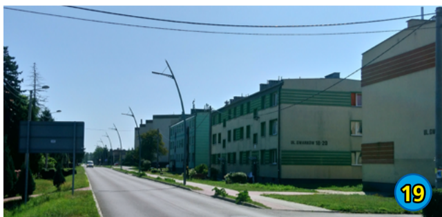
19. BUDOWA EFEKTYWNEGO ENERGETYCZNIE OŚWIETLENIA UL. GWARKÓW - 149 076,00 ZŁ
