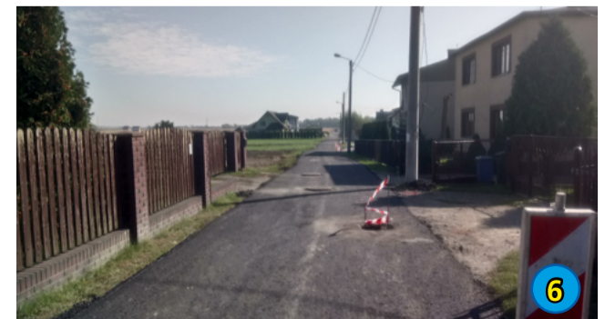
6. PRZEBUDOWA DROGI GMINNEJ UL. AZALIOWA - WYKONANIE NAWIERZCHNI ASFALTOBETONOWEJ - 182 573,82 ZŁ
