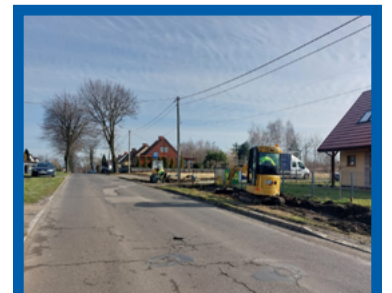
BUDOWA I MODERNIZACJA EFEKTYWNEGO ENERGETYCZNE OŚWIETLENIA DROGOWEGO W GMINIE ŁĘDZINY - 4 432 771,50 ZŁ
