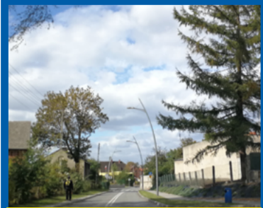
PRZEBUDOWA DROGI UL. PADEREWSKIEGO WRAZ Z OŚWIETLENIEM - 750 934,53 ZŁ
