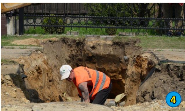
4. MODERNIZACJA UL. JEMIOŁOWEJ I BUDOWA SIECI WODOCIAGOWEJ - 67 111,41 ZŁ
