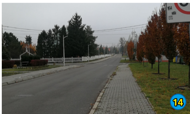
14. BUDOWA OŚWIETLENIA DROGOWEGO UL. RUBERGA - 108 855,00 ZŁ
