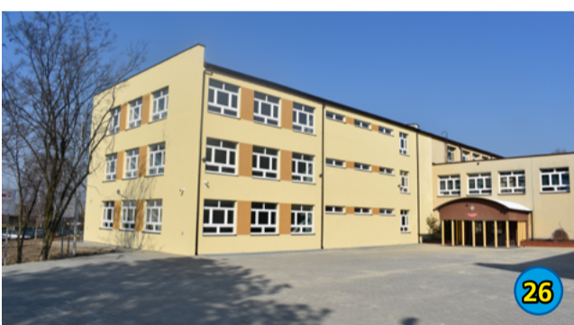
26. WPF - ROZBUDOWA I MODERNIZACJA SZKOŁY PODSTAWOWEJ Z ODDZIAŁAMI INTEGRACYJNYMI NR 1 - 869 881,83 ZŁ
