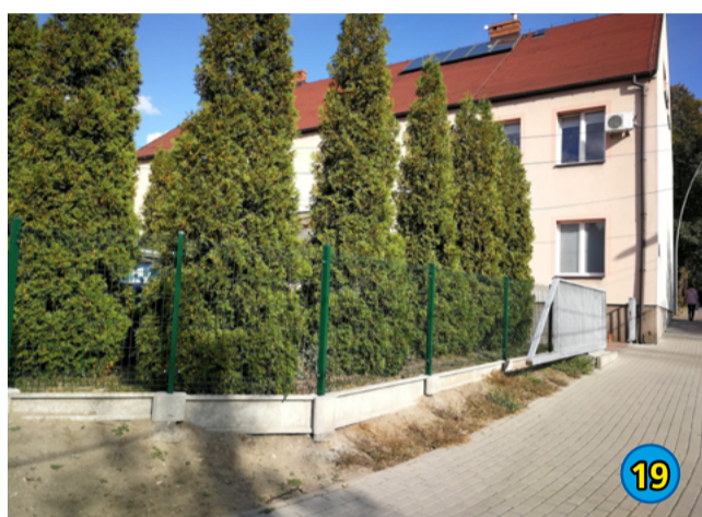
19. BUDOWA OGRODZENIA UL. ASNYKA 1 – 7 178,00 ZŁ
