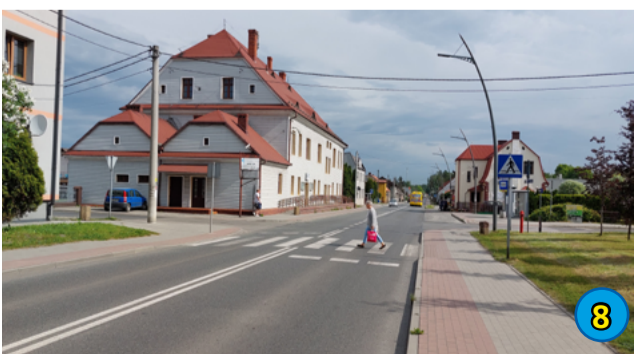
8. POPRAWA BEZPIECZEŃSTWA NA DROGACH PUBLICZNYCH - PRZEBUDOWA PRZEJŚCIA DLA PIESZYCH W CIĄGU UL. HOŁDUNOWSKIEJ NA SKRZYŻOWANIU Z ULICĄ GAJOWĄ - 39 750,00 ZŁ
