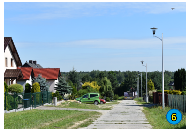
6. BUDOWA OŚWIETLENIA DROGOWEGO UL. POGODNA - 28 291,58 ZŁ
