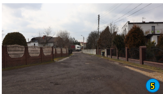
5. BUDOWA DROGI UL. HOŁDUNOWSKA Z WŁĄCZENIEM DO UL. GWARKÓW W ŁĘDZINACH - 50 384,00 ZŁ
