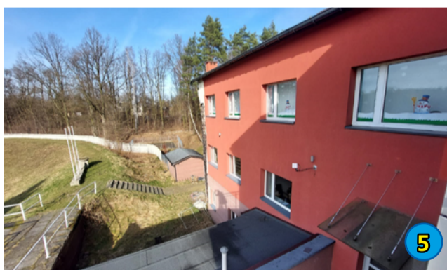
5. ROZBUDOWA BUDYNKU PRZY UL. STADIONOWEJ 1 (MKS) - 715 000,00 ZŁ
