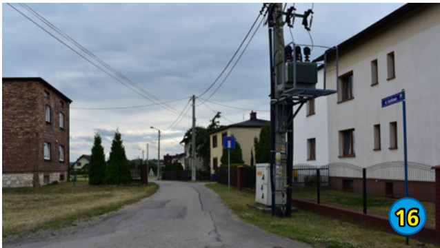
16. BUDOWA SIECI KANALIZACJI UL. AZALIOWA I CZAPLI - 464 085,90 ZŁ
