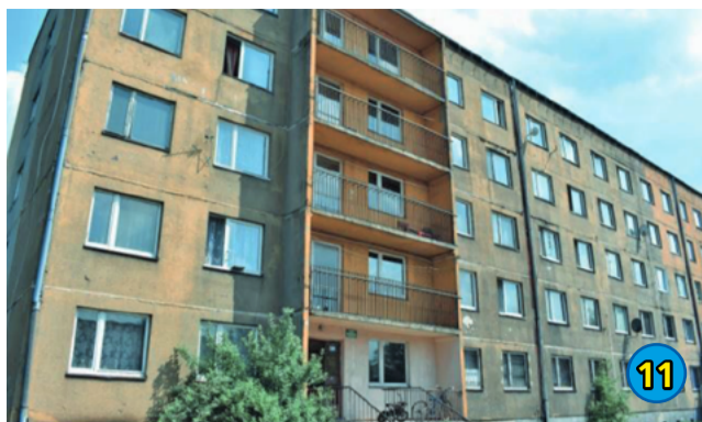
11. WPF - TERMOMODERNIZACJA BUDYNKU KOMUNALNEGO W ŁĘDZINACH PRZY UL. POKOJU 106 - 20 160,00 ZŁ
