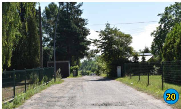
20. BUDOWA OŚWIETLENIA DROGOWEGO UL. SZKOLNA - 40 457,05 ZŁ
