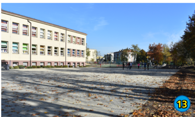
13. REMONT NAWIERZCHNI PLACU SZKOLNEGO SZKOŁY PODSTAWOWEJ NR 3 - 222 522,06 ZŁ
