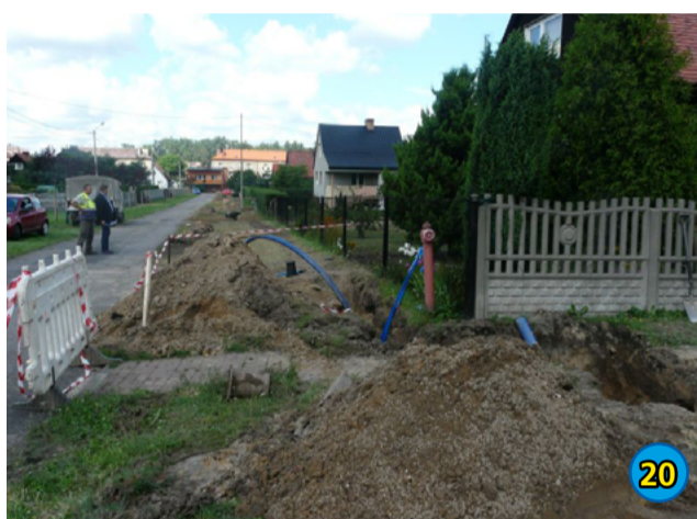
20. BUDOWA SIECI WODOCIĄGOWEJ W UL. LEWANDOWSKIEJ - 180 913,52 ZŁ
