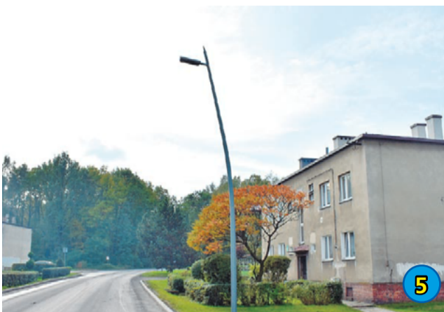
5. BUDOWA EFEKTYWNEGO ENERGETYCZNIE OŚWIETLENIA UL. OFICERSKA - 38 499,00 ZŁ
