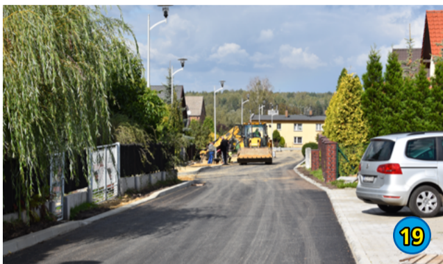
19. BUDOWA OŚWIETLENIA DROGOWEGO UL. SOSNOWA - 72 508,50 ZŁ
