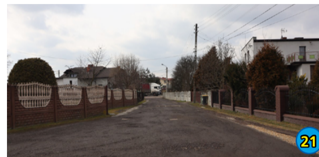
21. BUDOWA DROGI UL. HOŁDUNOWSKA „BOCZNA” Z WŁĄCZENIEM DO UL. GWARKÓW - 78 068,00 ZŁ
