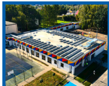
WPF - ROZBUDOWA SZKOŁY PODSTAWOWEJ NR 2 W ŁĘDZINACH - 9 174 807,53 ZŁ
