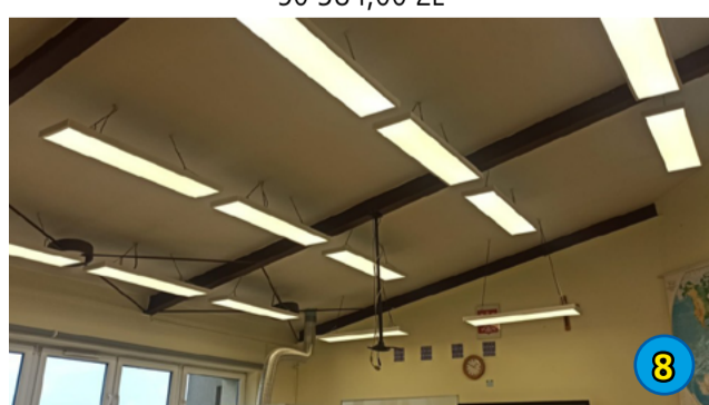
8. MODERNIZACJA INSTALACJI OŚWIETLENIA NA ENERGOOSZCZĘDNE W BUDYNKU SZKOŁY PODSTAWOWEJ NR 4 W ŁĘDZINACH - 77 524,25 ZŁ
