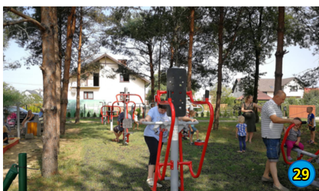
29. BUDOWA SIŁOWNI ZEWNĘTRZNEJ UL. JAGIEŁOŃSKA - 54 888,59 ZŁ
