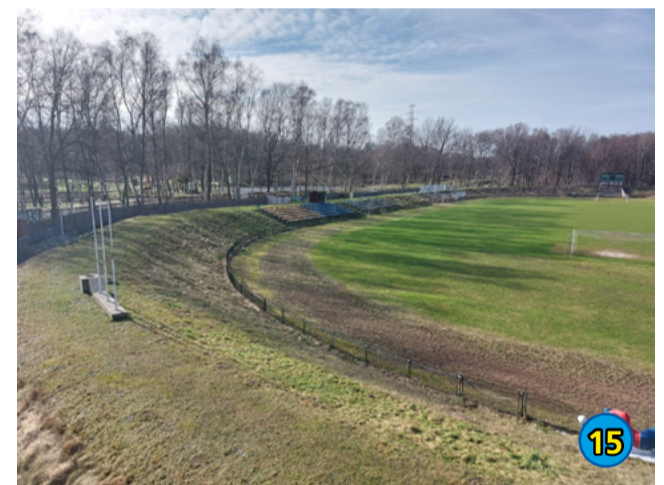
15. MODERNIZACJA STADIONU MKS ŁĘDZINY - 125 729,37 ZŁ
