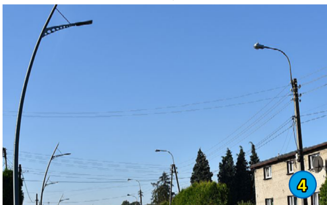
4. BUDOWA EFEKTYWNEGO ENERGETYCZNIE OŚWIETLENIA DROGOWEGO - 830 545,20 ZŁ
