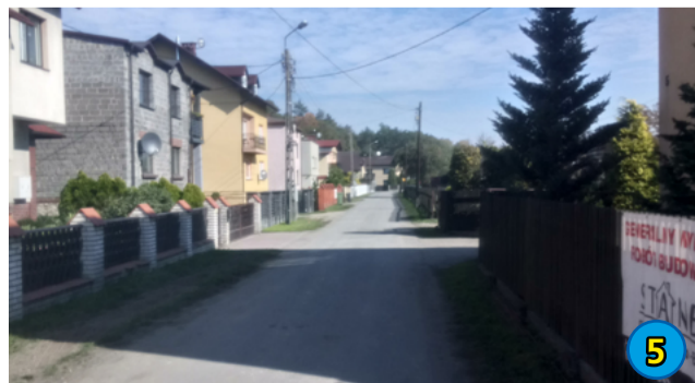
5. PRZEBUDOWA DROGI GMINNEJ WRAZ Z EFEKTYWNYM ENERGETYCZNIE OŚWIETLIENIEM DROGOWYM UL. LEŚNA - 75 891,00 ZŁ
