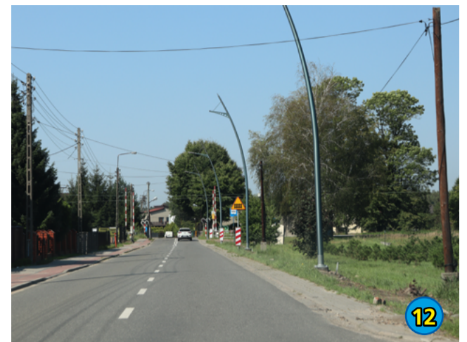
12. BUDOWA OŚWIETLENIA DROGOWEGO UL. MURCKOWSKA - 106 946,70 ZŁ
