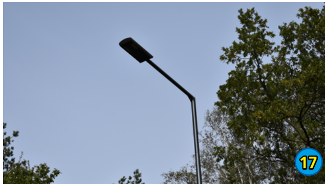
17. BUDOWA OŚWIETLENIA DROGOWEGO UL. ŁĘDZIŃSKA - 135 605,94 ZŁ
