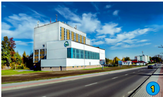
1. KOMPLEKSOWA MODERNIZACJA OŚRODKA REKREACYJNO-SPORTOWEGO CENTRUM - 4 200 000,00 ZŁ
