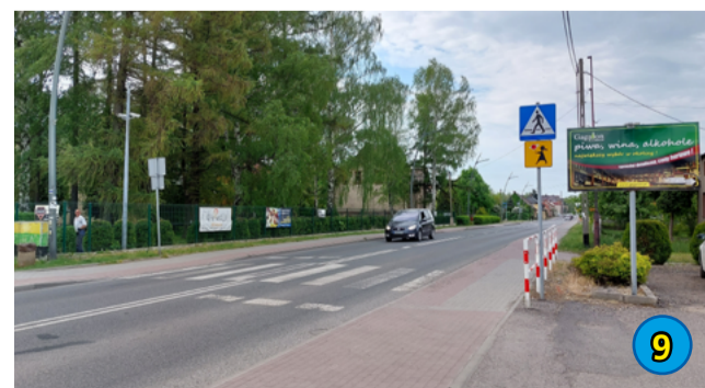
9. POPRAWA BEZPIECZEŃSTWA NA DROGACH PUBLICZNYCH - PRZEBUDOWA PRZEJŚCIA DLA PIESZYCH W CIĄGU UL. HOŁDUNOWSKIEJ W REJONIE SZKOŁY PODSTAWOWEJ NR 2 - 39 750,00 ZŁ
