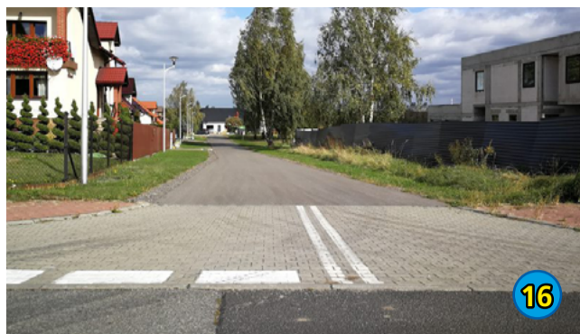
16. MODERNIZACJA UL. RÓŻANEJ – 87 155,13 ZŁ
