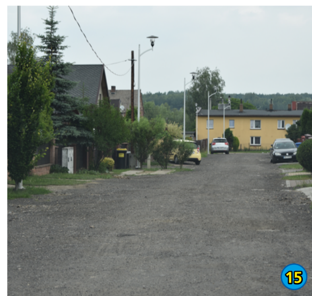
15. BUDOWA SIECI WODOCIĄGOWEJ UL. SOSNOWA I KWIATOWA - 219 509,96 ZŁ
