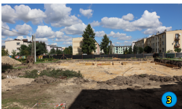
3. WPF - ROZBUDOWA SZKOŁY PODSTAWOWEJ NR 2 W ŁĘDZINACH - 3 818 424,36 ZŁ
