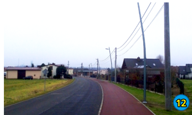
12. BUDOWA OŚWIETLENIA DROGOWEGO UL. DZIKOWA - 104 506,67 ZŁ
