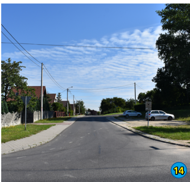
14. BUDOWA SIECI WODOCIĄGOWEJ UL. LEWANDOWSKIEJ - 148 591,47 ZŁ
