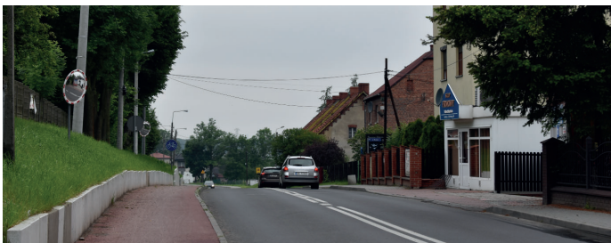
Nazwa zadania: Budowa efektywnego energetycznie oświetlenia drogowego (ul. Kontnego) Zadanie: Likwidacja starego oświetlenia drogowego na nowe oświetlenie LED. Inwestycja dofinansowana w 85% ze środków GZM. Wartość inwestycji: 155 841,00 zł Wykonawcy: COPCO Sp. z o.o. Imielin
