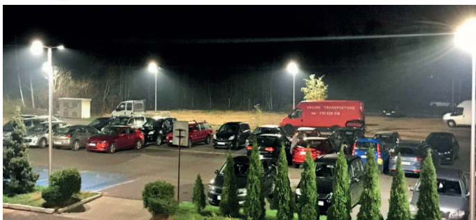
Nazwa zadania: Wymiana oświetlenia drogowego na efektywne energetycznie ul. Gałczyńskiego, Zabytkowa, Wypiańskiego, Parking ORS „Centrum” Zadanie: W ramach zadania dokonano wymiany latarni oświetleniowych na nowe Wartość inwestycji: 159 039,00 zł Wykonawca: COPCCO Plus Sp. z o.o.
