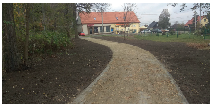
Nazwa zadania: Budowa chodnika od ul. Ekonomicznej do ul. Fredry Zadanie: W ramach zadania wybudowano chodnik od ul. Ekonomicznej do ul. Fredry. I Etap inwestycji. Wartość inwestycji: 145 120,00 zł Wykonawca: P.P.H.U. BAL-MAR Piotr Malcharek z Bojszów
