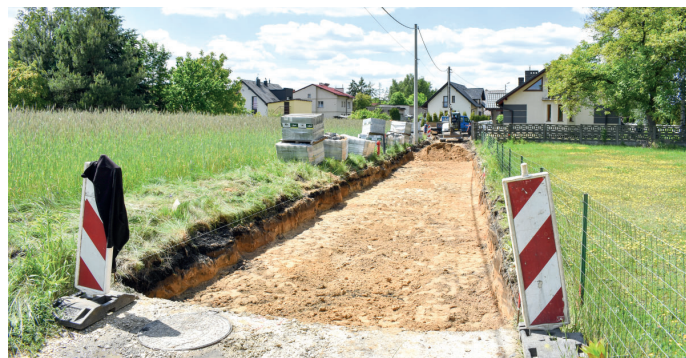
Nazwa zadania: Przebudowa drogi ul. Plebiscytowej Zadanie: Wykonanie podbudowy drogi wraz z nawierzchnią z kostki betonowej oraz odwodnienia na długości ok. 400 metrów. Wartość inwestycji: 450 000,00 zł Wykonawcy: Barański Adam FUH „AB-S” Chrzanów
