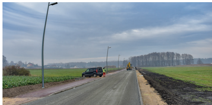
Nazwa zadania: Budowa drogi gminnej ul. Blych Zadanie: W ramach zadania przewidziano budowę drogi gminnej, budowę oświetlenia przebudowę odwodnienia, linii naziemnej nN i odcinka gazociągu. Inwestycję zakończono. Wartość inwestycji: 3 553 616,25 zł Wykonawca: Przedsiębiorstwo Budowy Dróg „Drogopol-ZW” sp. z o.o.
