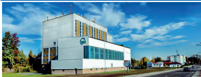
Nazwa zadania: Kompleksowa modernizacja Ośrodka Rekreacyjno-Sportowego „Centrum” Zadanie: demontaż istniejącego pokrycia dachowego, docieplenie dachu, wykonanie pokrycia dachowego, wykonanie nowego oświetlenia sali sportowej, wykonanie obróbek blacharskich, odwodnienia dachu oraz instalacji odgromowej. Wykonawcy: Trwa procedura przetargowa
