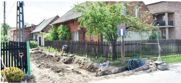
Nazwa zadania: Przebudowa drogi gminnej ul. Modra wraz z oświetleniem drogowym Zadanie: Wykonanie podbudowy drogi wraz z nawierzchnią z kostki betonowej oraz odwodnienia. Wartość inwestycji: 222 247,81 zł Wykonawcy: Przedsiębiorstwo Robót drogowych Grzegorz Opitek Chełm Śląski
