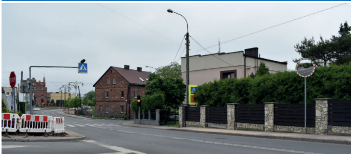
Nazwa zadania: Budowa efektywnego energetycznie oświetlenia drogowego (ul. Łędzińska) Zadanie: Likwidacja starego oświetlenia drogowego na nowe oświetlenie LED od ul. Górniczej do ul. Pokoju. Inwestycja dofinansowana w 85% ze środków GZM. Wartość inwestycji: 489 171,00 zł Wykonawcy: COPCO Sp. z o.o. Imielin
