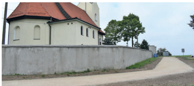
Nazwa zadania: Remont chodnika wokół kościoła św. Klemensa Zadanie: Wykonano nową nawierzchnię chodnika z kostki betonowej Wartość inwestycji: 102 901,41 zł Wykonawca: Przedsiębiorstwo Robót Drogowych Grzegorz Opitek
