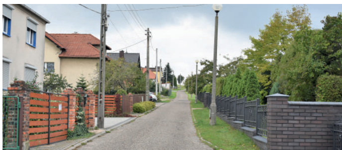
Nazwa zadania: Wymiana oświetlenia drogowego na efektywne energetycznie ul. Gałczyńskiego, Zabytkowa, Wyspiańskiego, parking ORS „Centrum” Zadanie: Wymiana istniejących stojących latarni na nowe. Wartość inwestycji: 157 071,00 zł Wykonawca: COPCO Plus Sp. z o. o.
