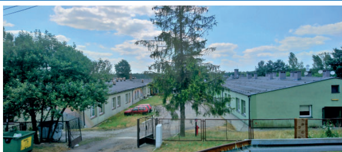
Nazwa zadania: Termomodernizacja budynku komunalnego przy ul. Pokoju 37 w Łędzinach Zadanie: Zakres prac obejmuje ocieplenie dachu, remont instalacji odgromowej i rynien. Zadanie dofinansowane zostało z Metropolii. Wartość inwestycji: 289 000,00 zł Wykonawca: Stanisław Oleksy Zakład Remontowo-Budowlany „BUDOLEX”
