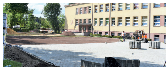
Nazwa zadania: Remonty nawierzchni z płyt betonowych i kostki betonowej - plac szkolny przy SP 3 Zadanie: Rozebrana została stara nawierzchnia oraz wykonano podbudowę z tłuczni kamienno. Trwają prace związane z położeniem nowej nawierzchni z kostki betonowej. Wartość inwestycji: 192 522,06 zł Wykonawca: INFRAOX sp. z o.o.
