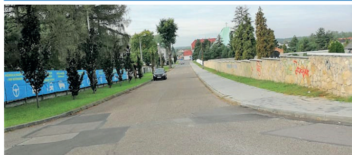
Nazwa zadania: Budowa oświetlenia ul. Ruberga Zadanie: Zabudowa nowych latarni wraz z siecią kablową. Wartość inwestycji: 106 272,00 zł Wykonawca: Instalatorstwo Elektryczne Mieczysław Kostka z siedzibą w Bojszowach
