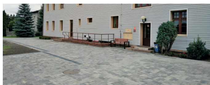
Nazwa zadania: Wykonanie parkingu z kostki brukowej Zadanie: Wykonanie parkingu na terenie Miejskiego Ośrodka Kultury, rozebranie starej nawierzchni, wykonanie podbudowy z kruszywa, wykonanie obrzeży oraz ułożenie kostki typu wenecja. Wartość inwestycji: 114 600,00 zł Wykonawca: ORI Bruk Usługi Brukarskie
