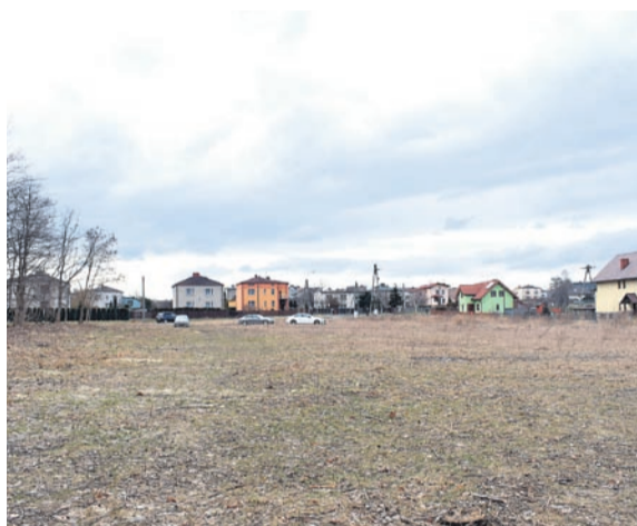
Teren na którym powstaje przedszkole
